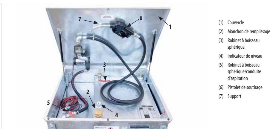
MT 1000 équipé d'une pompe électrique
