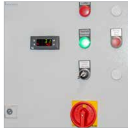
Schaltschrank mit digitaler Temperaturanzeige
