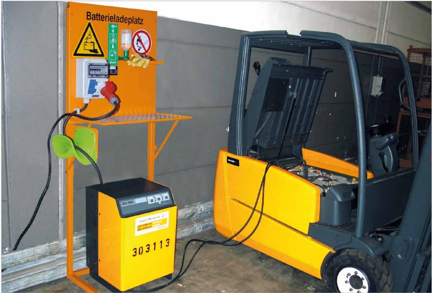
BL mit CEEform Steckdose 400 V beim Aufladen eines Elektro-Gabelstaplers
